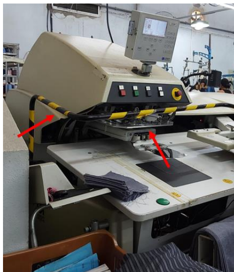
Foto: Instalada barreira metálica na máquina de pregar bolsos para sinalizar a área de risco, no entanto o operador tem acesso à zona perigosa. Deve-se verificar a possibilidade de instalação de detectores de presença optoeletrônicos impedindo que a máquina inicie os movimentos perigosos (prensa e costura do bolso), caso seja detectado que o operador está com os braços e mãos na zona de risco. Autores, 2022.
