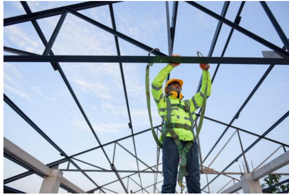
Atividade de Trabalho em Altura
