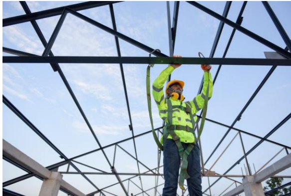
Atividade de Trabalho em Altura
