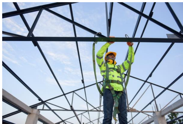
Atividade de Trabalho em Altura
