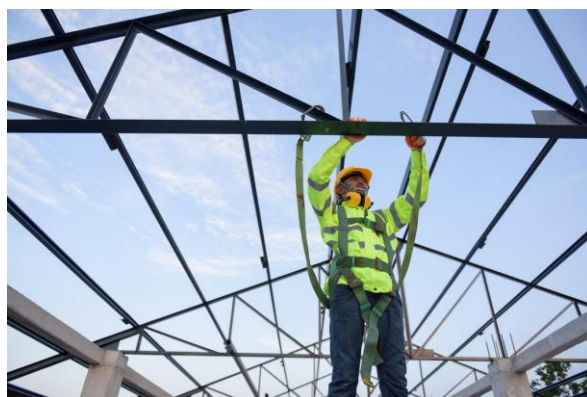
Atividade de Trabalho em Altura
