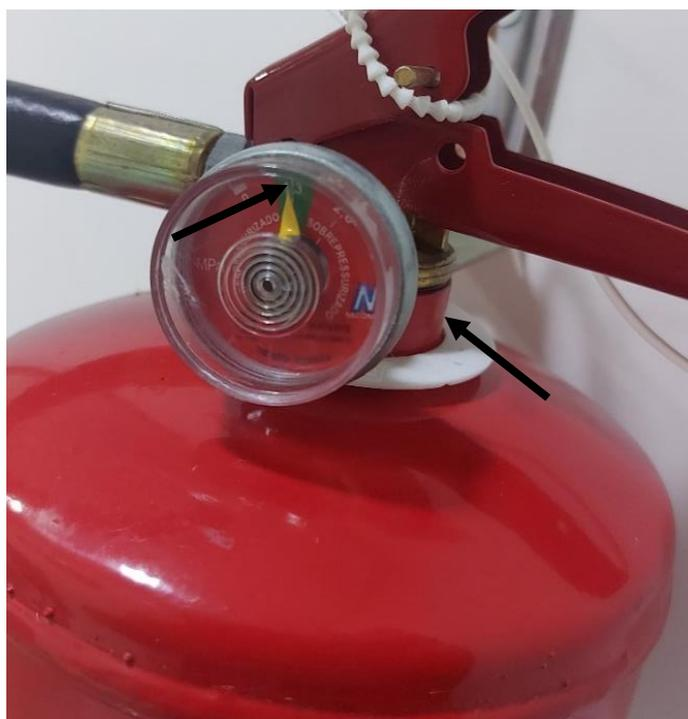
Figura 31: detalhe do anel de manutenção na cor branco referente ao ano de 2021 e do manômetro indicando pressão adequada do extintor. | Foto: Autores, 2022.
