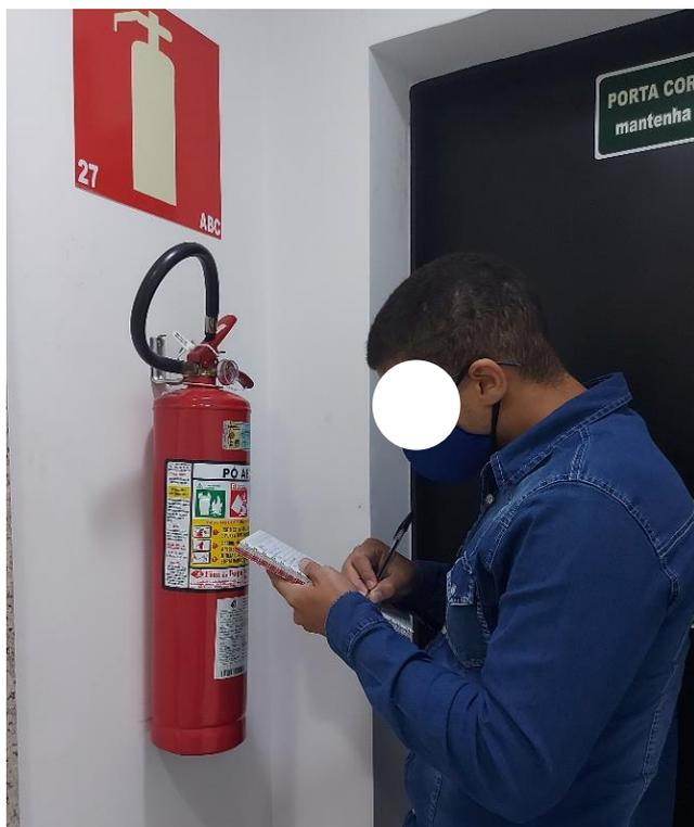
Figura 32: o sistema de combate a incêndio deve ser periodicamente inspecionado e os registros dessas inspeções devem ser mantidos. | Foto: Autores, 2022.
