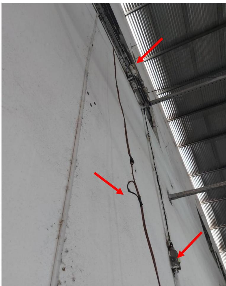
Figura 8: fiação elétrica com emendas sem isolamento adequado e fora de eletrocalhas. | Foto: Autores, 2022.
