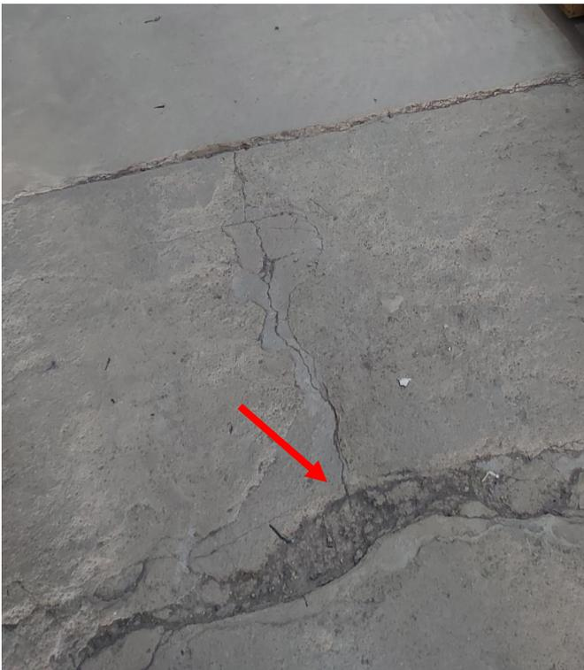
Figura 7: piso de trabalho com depressões gerando risco de queda e dificultando o transporte de materiais em carrinhos. | Foto: Autores, 2022.
