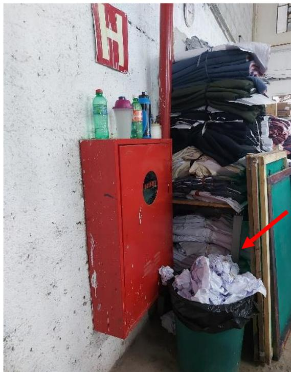
Figura 30: armazenamento de materiais causando obstrução dos equipamentos de combate à incêndios. | Foto: Autores, 2022.
