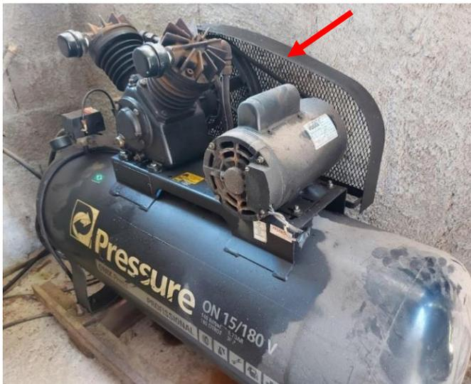
Figura 18: vaso de pressão instalado em local aberto, mas sem sinalização. A proteção instalada na correia de transmissão de força é parcial e não garante total proteção contra contato acidental (ver NR-12). O compressor foi instalado sobre piso desnivelado e para corrigir o desnível foram utilizados pedaços de madeira, mas sem a fixação adequada. | Foto: Autores, 2022.
